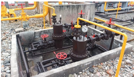
管道防腐处理
