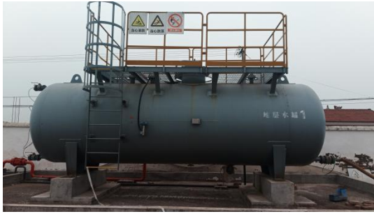
20m³ 钢制污水罐
