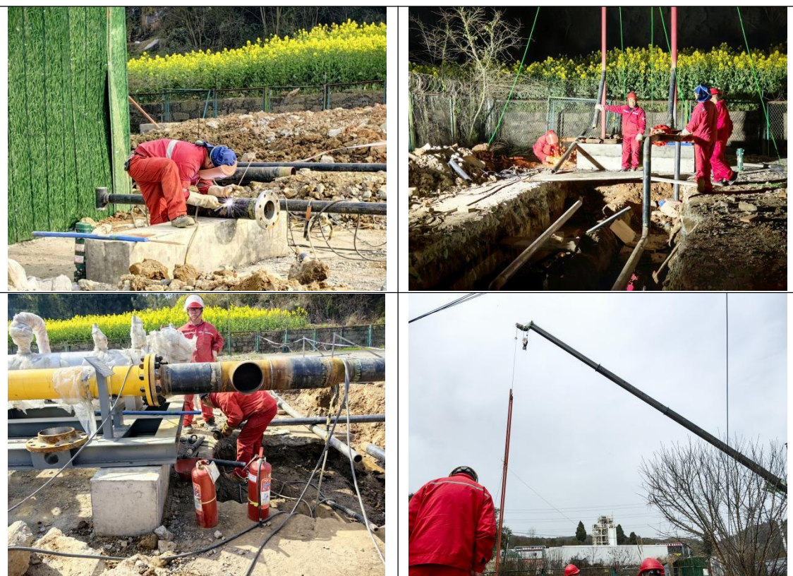
施工期施工照片
